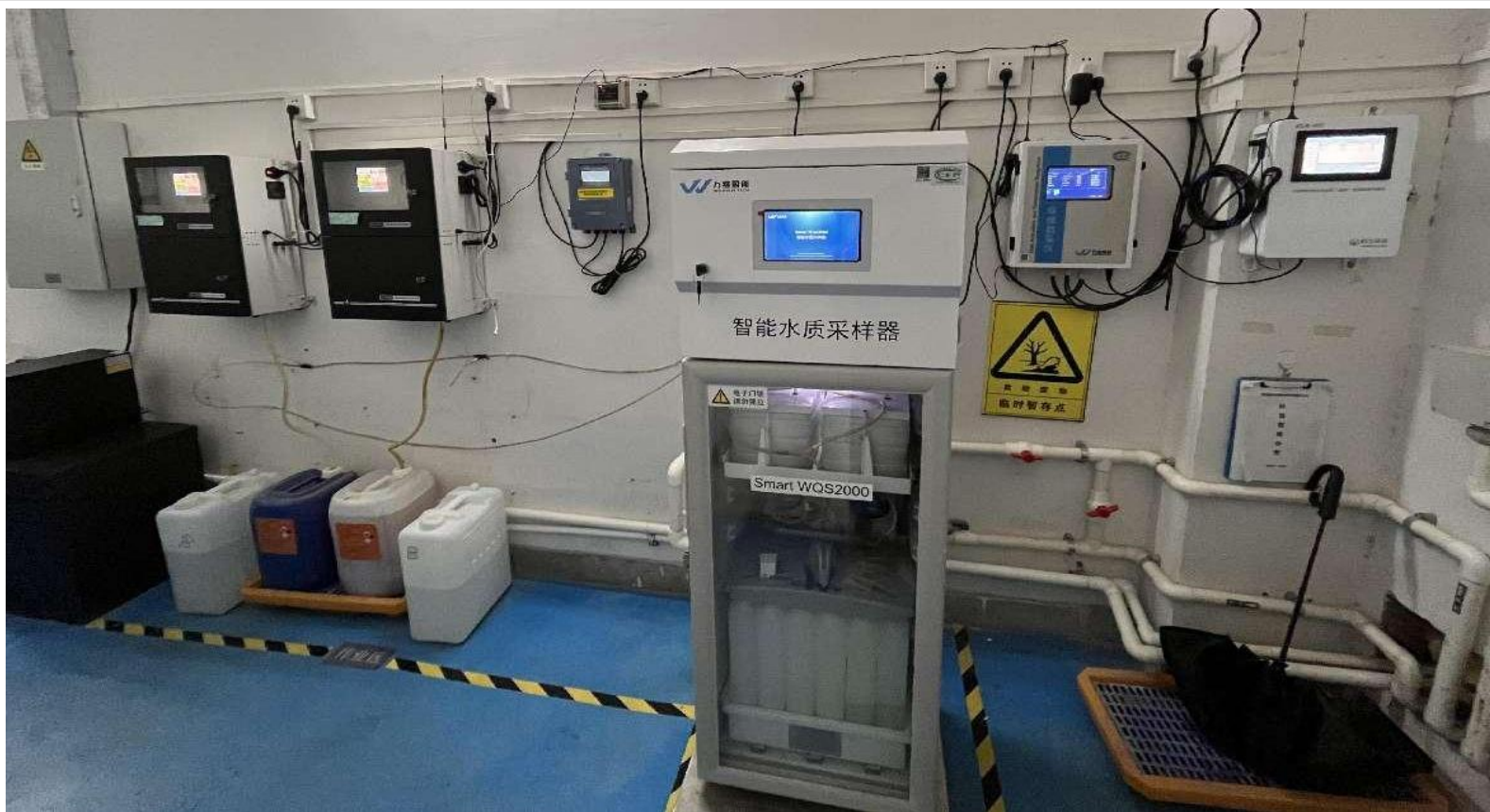
水污染源在线监测站房现场照片（COD、氨氮、pH、流量计在线监测系统）
